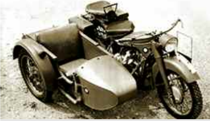
Alman Ordusu için Üretilen Teleskopik Ön Süspansiyonlu Bir BMW R12
